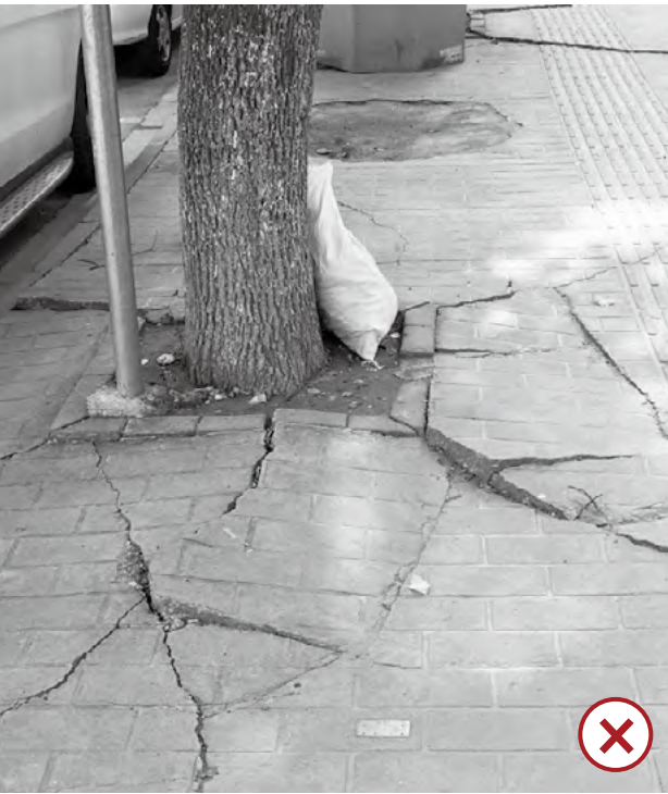
■ 过度硬化，浅根系植物破坏路面
