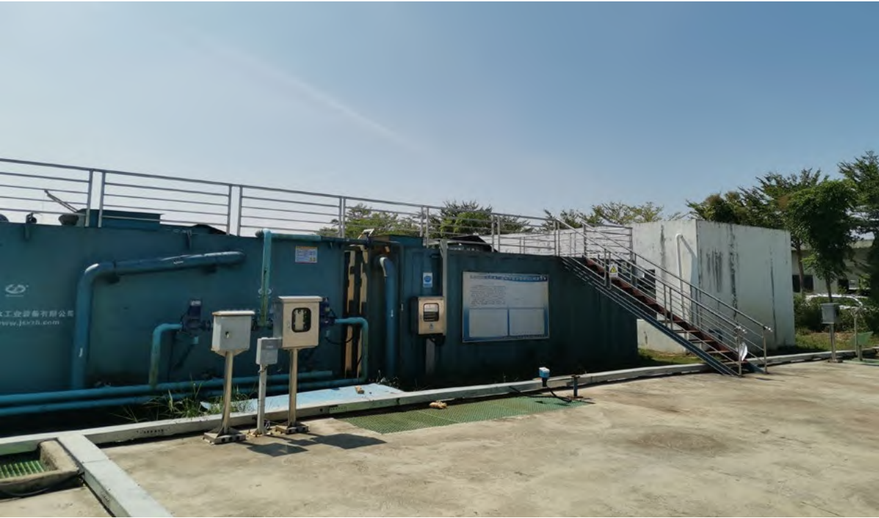
装配式污水处理设施是指在工厂加工制作模块化单元体，整体运输和现场安装，并配套实施连接所建成的污水处理设施，包括装配式污水处理厂和污水处理一体化装置。
