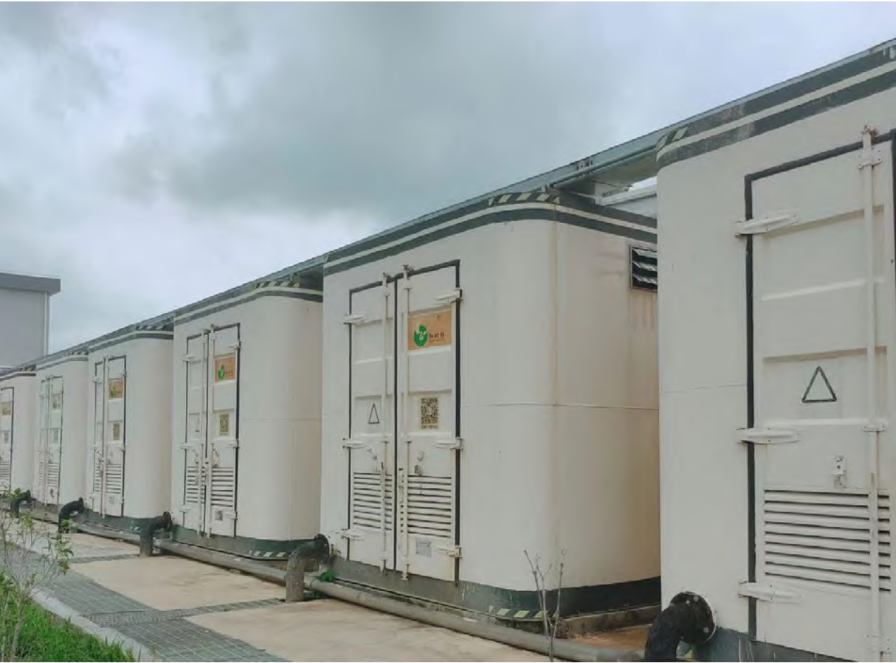
装配式污水处理设施是指在工厂加工制作模块化单元体，整体运输和现场安装，并配套实施连接所建成的污水处理设施，包括装配式污水处理厂和污水处理一体化装置。
