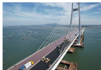
阳江海陵大堤至溪头段（含阳江港大桥）公路工程
