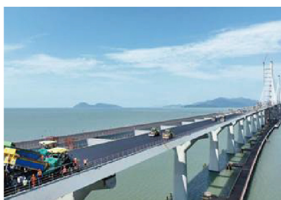
黄茅海跨海通道
