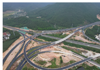
江门蓬江至新会高速公路（银洲湖高速公路）
