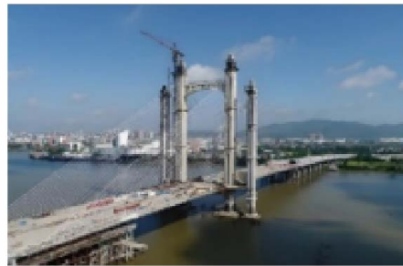
开平东环大桥
