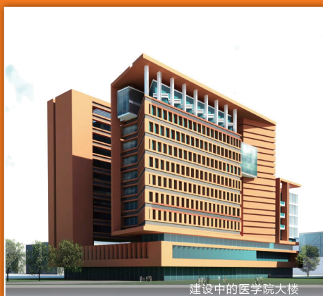
建设中的医学院大楼
